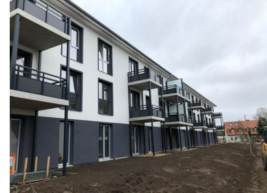
Haus 3 – Balkonanlage und Außenanlagen
