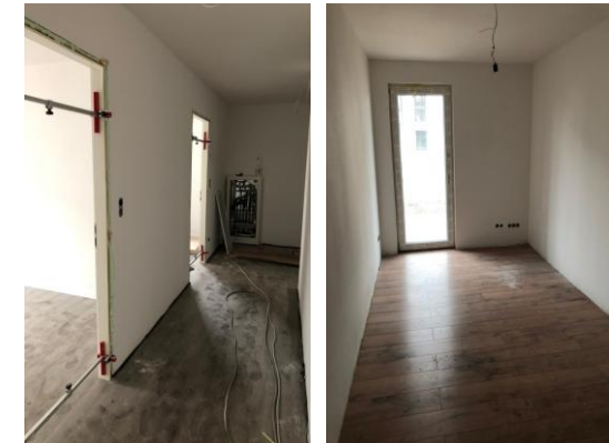
Haus 2 Anbringen der Türzargen
