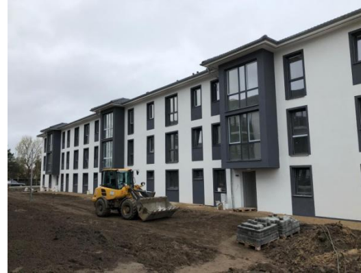
Haus 2 mit Arbeiten an den Außenanlagen
