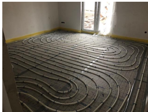
Haus 5 – Installation der Fußbodenheizung
