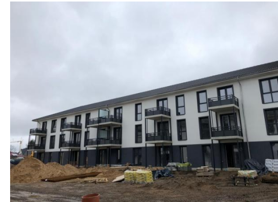
Haus 3 Treppenhaus und Elektroarbeiten
