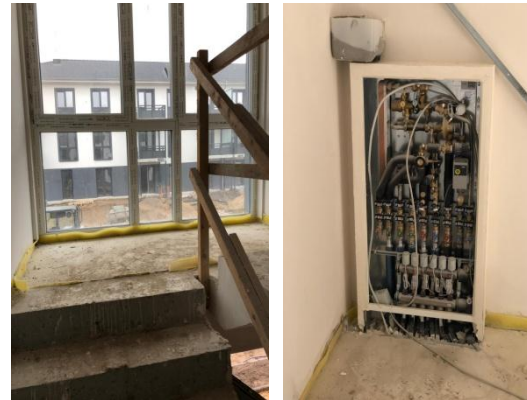
Haus 3 - Treppenhaus und Elektroarbeiten
