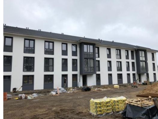
Haus 3 - Arbeiten an den Außenanlagen
