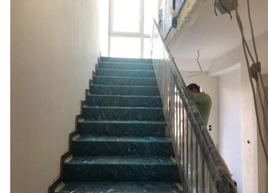
Haus 4 – Treppengelände z. T. angebracht, Fliesen verlegt
