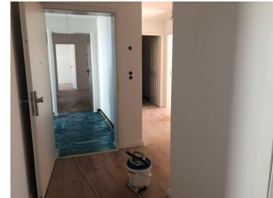
Haus 4 – Innenputz wird finalisiert
