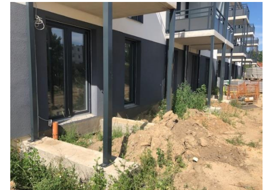
Haus 6 – Balkone angebracht, Terrassen in Vorbereitung
