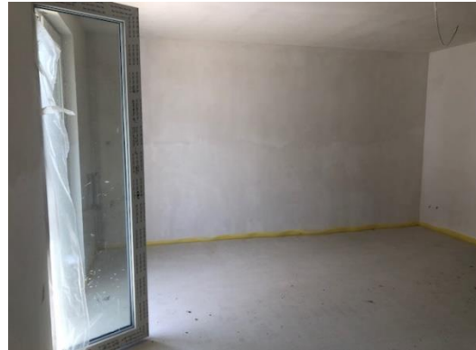
Haus 5 & 6 – Estrich in allen Wohnungen gegossen
