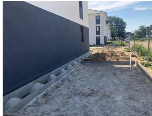
Haus 4 – Letzte Fundamentarbeiten für die Terrasse
