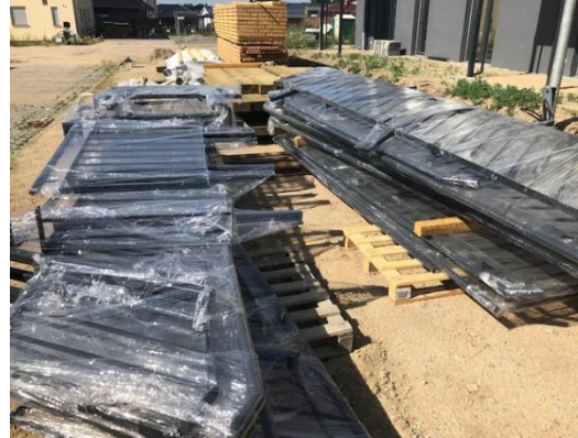
Haus 4 – Treppengeländer sind bereit zur Installation
