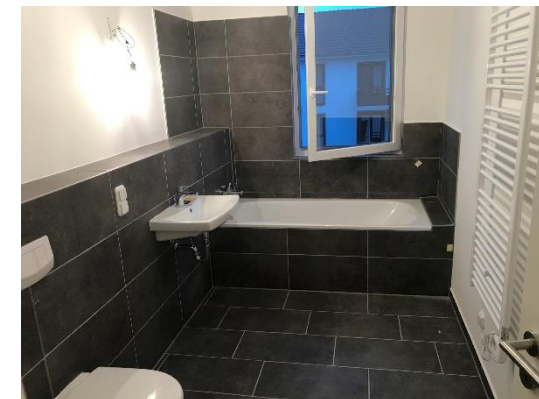
Haus 3 – Wohnungen fertig zur Übergabe
