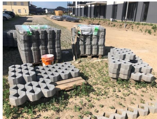
Haus 3 und 4 – Pflasterarbeiten zwischen 3 & 4
