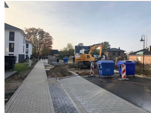
Fertigstellung der Emmy-Noether-Straße
