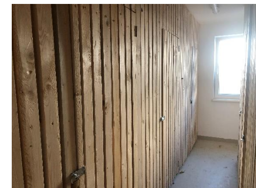
Ansicht Abstellraumabteile im EG der Häuser
