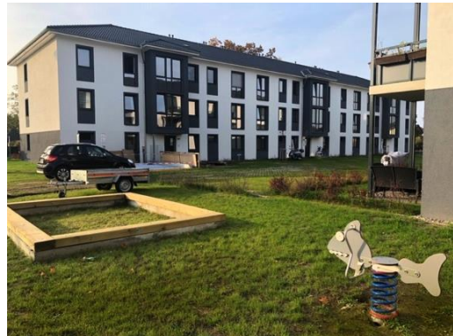
Außenanlage vor den Häusern 1 & 2
